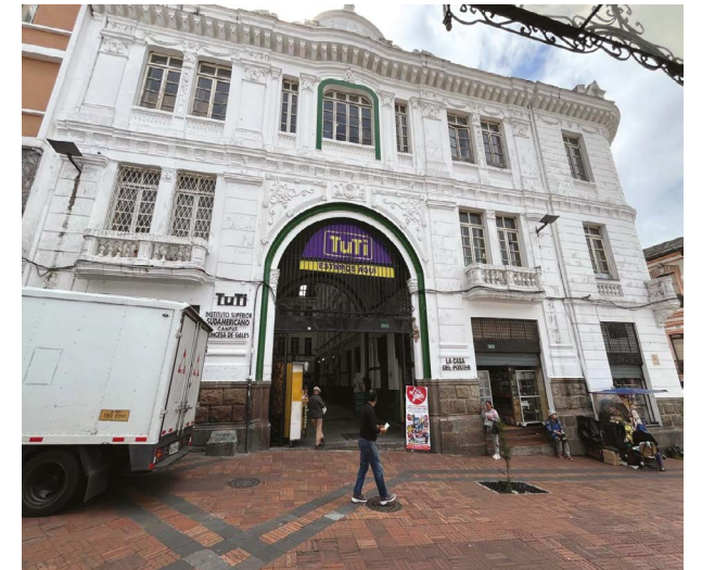
Las fotografía es de autoría propia, capturada en los recorridos del sitio.
