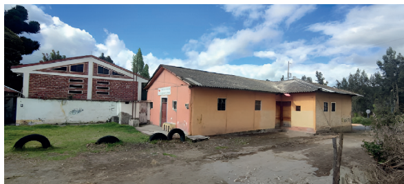
Nota: Equipamiento abandonado
