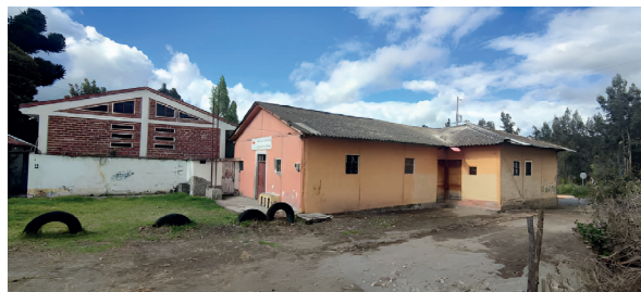
Nota: Equipamiento abandonado.
