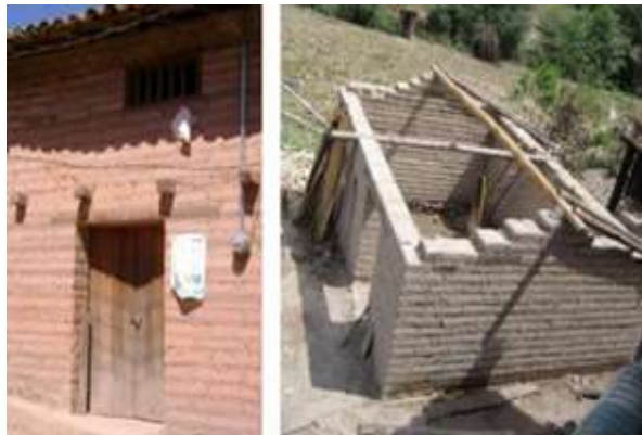
Figura 1 Vivienda en proceso de adaptación.
