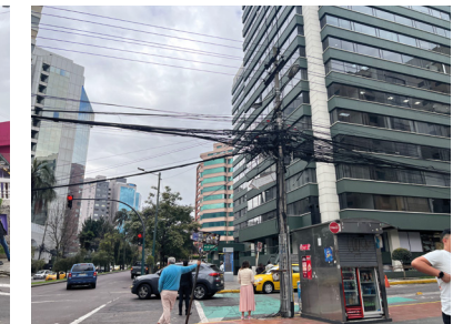
F6. Av. 12 de Octubre Alto flujo vehicular y peatonal en la zona financiera. Falta de mantenimiento en la señalética.
