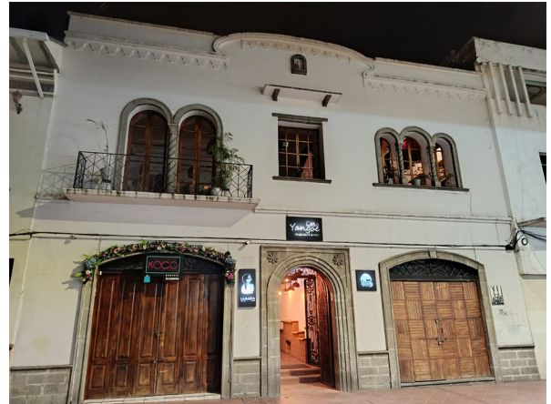
Figura O4. Casa Yangoe, Benigno Malo 5-16 y calle larga
