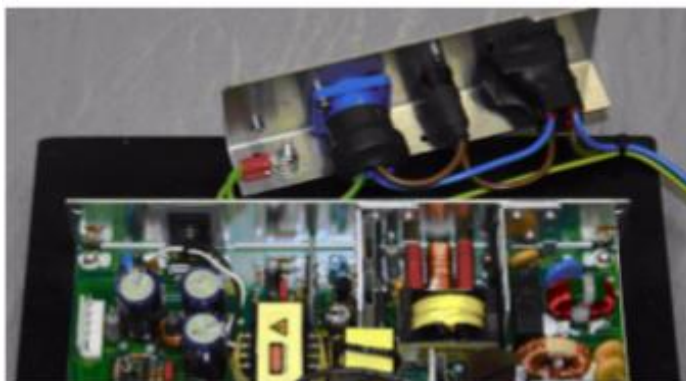
Figura N° 30: Colocación interruptores nuevos
