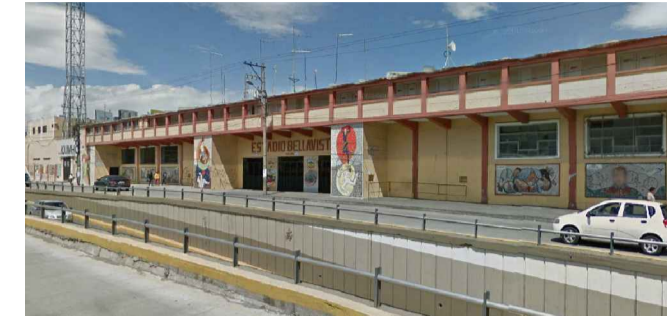
FOTOGRAFIA: GOOGLE EARTH FACHADA EXISTENTE SECTOR AVENIDA BOLIVARIANA
