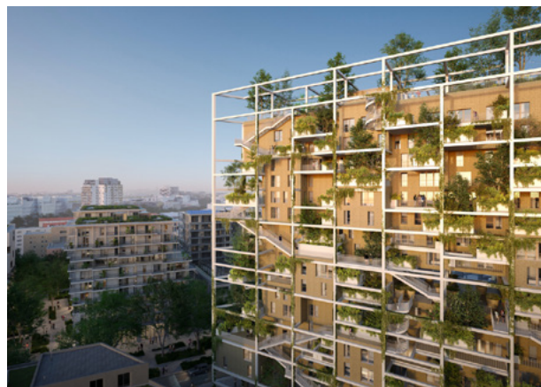
Figura 19. Estructura vista La Serre
