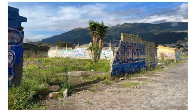
Figura 9. Vandalismo e inseguridad en el barrio El Rosario
