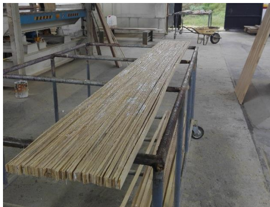
Figura 13: Proceso de armado de tablero
