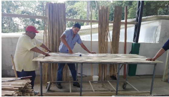
Figura 14: Proceso de encolado
