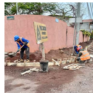
Figura 32. Aceras construidas en ciertos tramos zona urbana
