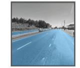
LA AV. SIMON BOLIVAR PERMITIÓ UNA MEJOR Y MÁS RÁPIDA COMUNICACIÓN. DEBIDO A LA FUERTE PENDIENTE NO SE SE PRODUJO LA DENSIFICACIÓN QUE SE ESPERABA
