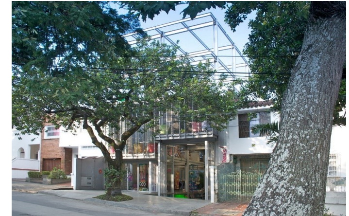
Gráfico 66. Edificio pre-expansión Fuente: Salinas, 2012
