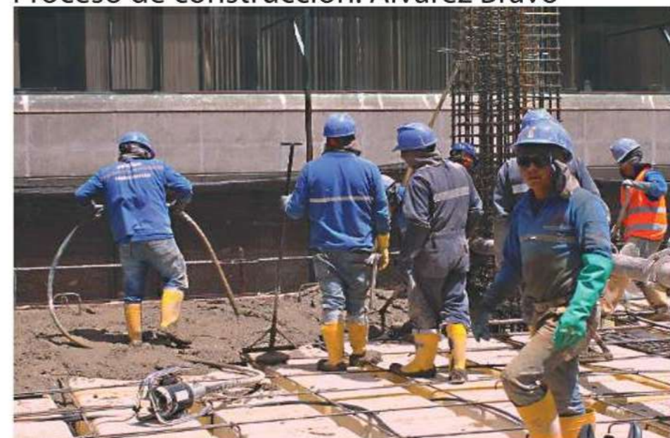
Proceso de construcción: Álvarez Bravo
