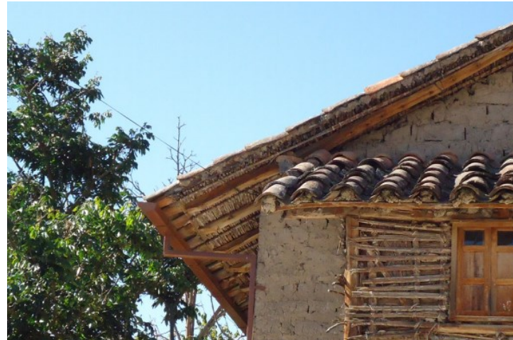
Gráfico 39. Edificación construida con material de alta inercia térmica, Tapial Fuente: INER, 2017
