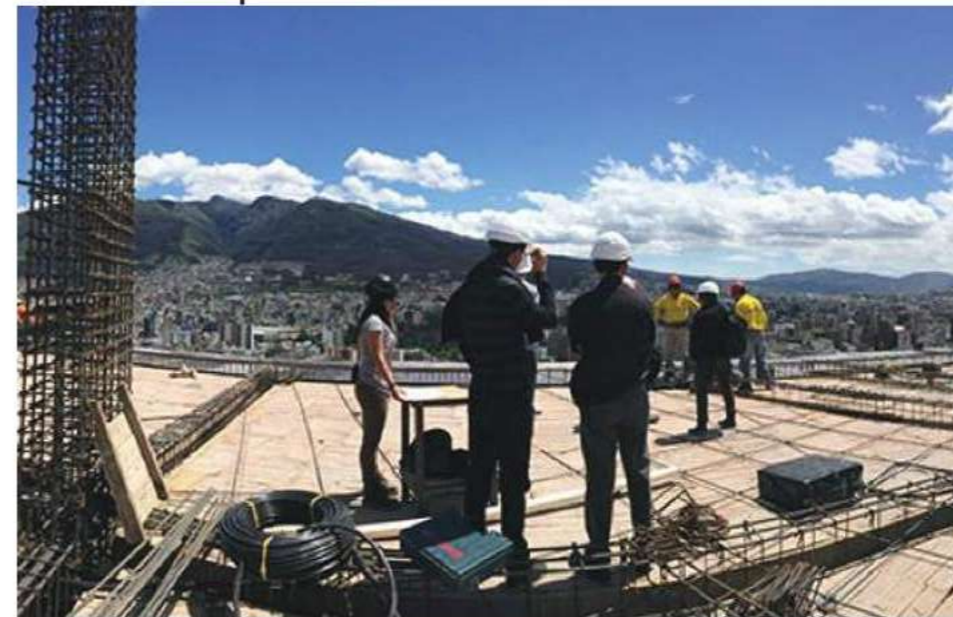
Proceso de construcción: Álvarez Bravo
