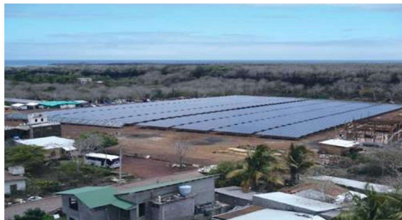
Proyecto fotovoltaico en Santa Cruz. (2014)
