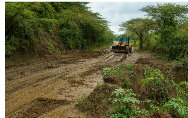
Figura 39. Vías sin pavimentar
