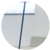
Ventanal de Cristal Templado con perifería de acero
