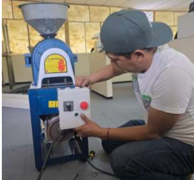
Imagen 8: Caja de control instalada en la carcasa del molino. Elaborado por: Delgado, Carlos (2025).
