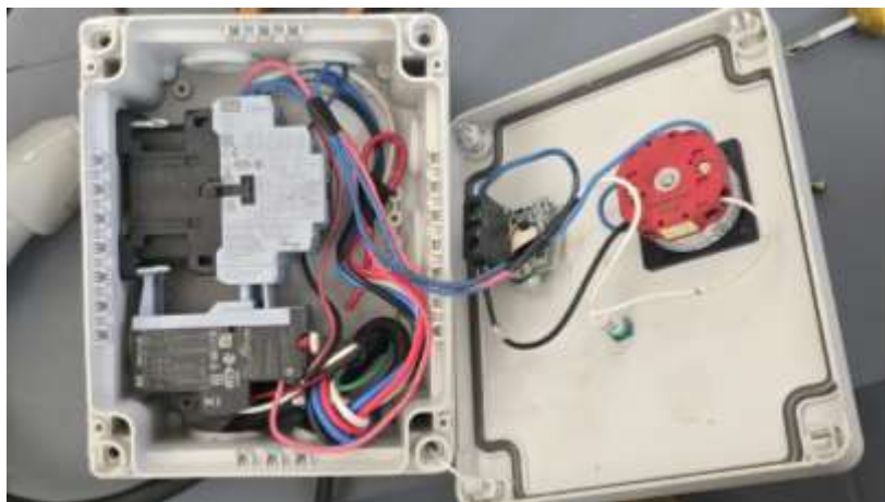
Imagen 7: Conexiones de la Botonera instalada en el molino. Elaborado por: Delgado, Carlos (2025).
