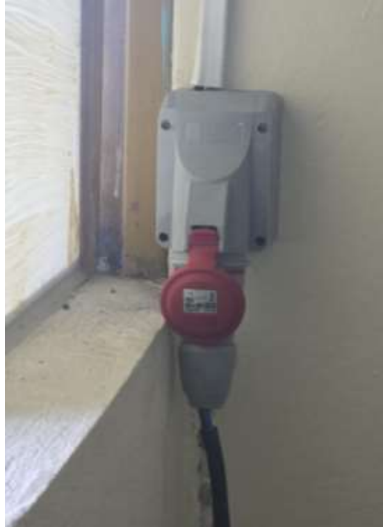
Imagen 6: Toma industrial instalada para conectar el molino. Elaborado por: Delgado, Carlos (2025).
