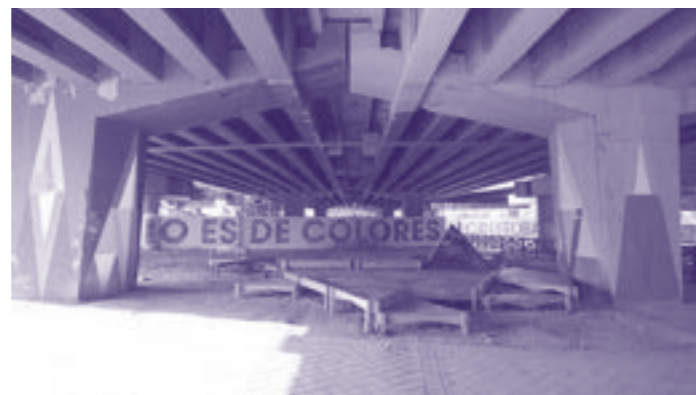
Figura 15. Puente de Colores de Madrid.
