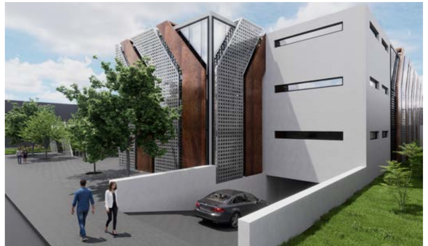
Figura 116. Entrada al Subsuelo
