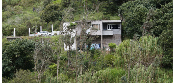
Figura 125. Vulnerabilidad en viviendas
