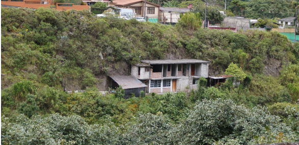
Figura 124. Vulnerabilidad en viviendas
