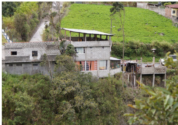
Figura O6. Vivienda en condiciones inadecuadas.
