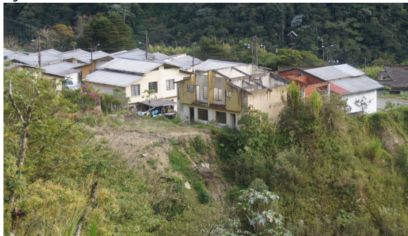
Figura 08. Viviendas afectadas Río Blanco.
