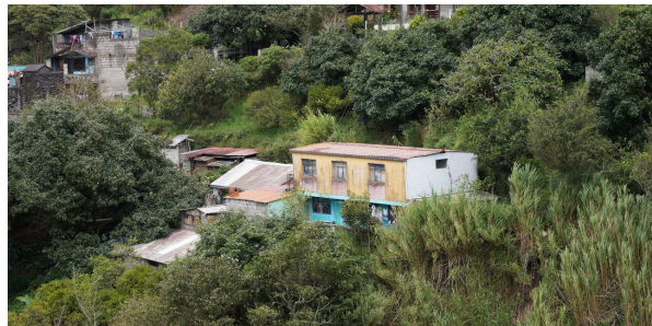
Figura 129. Vulnerabilidad en viviendas
