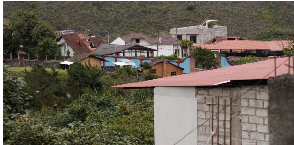
Figura 127. Vulnerabilidad en viviendas
