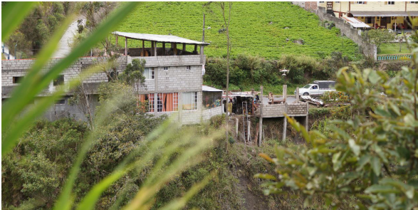
Figura 126. Vulnerabilidad en viviendas
