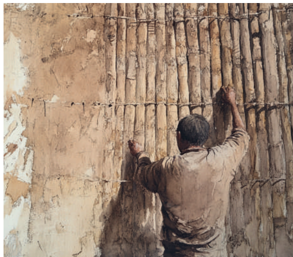
Figura 12. Técnica constructiva de bahareque
