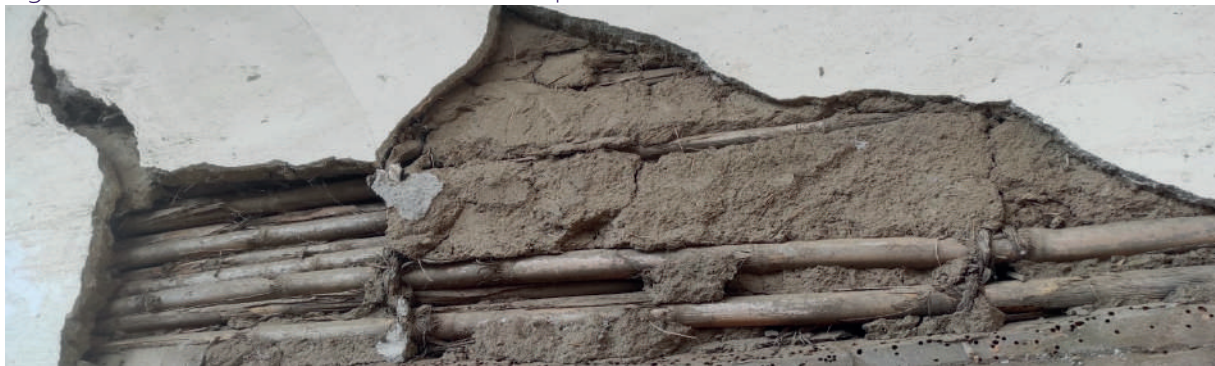
Figura 13. Sistema constructivo de bahareque
