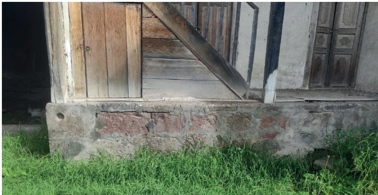
Figura 81. Zócalo de piedra pishilata de vivienda patrimonial
