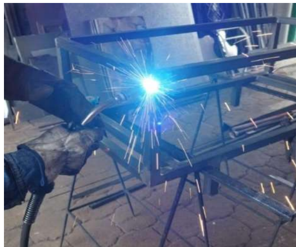
Figura 24 Soldadura de perfiles
