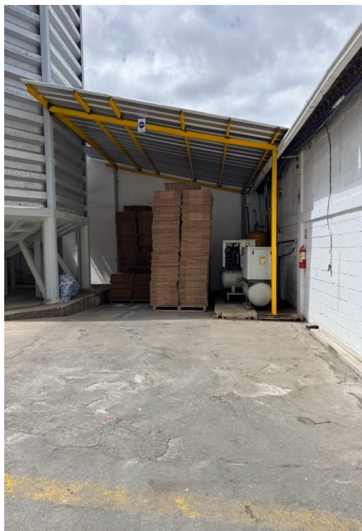
Anexo 5. Zona de almacenamiento de extruido de maíz
