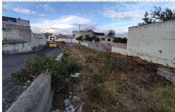
Nota: Presencia de vegetación invadiendo a la vía férrea
