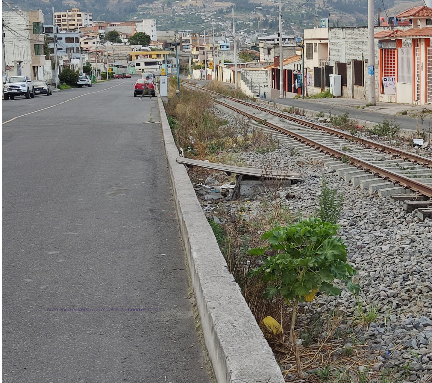
Figura 52 Estado actual de la zona 4
