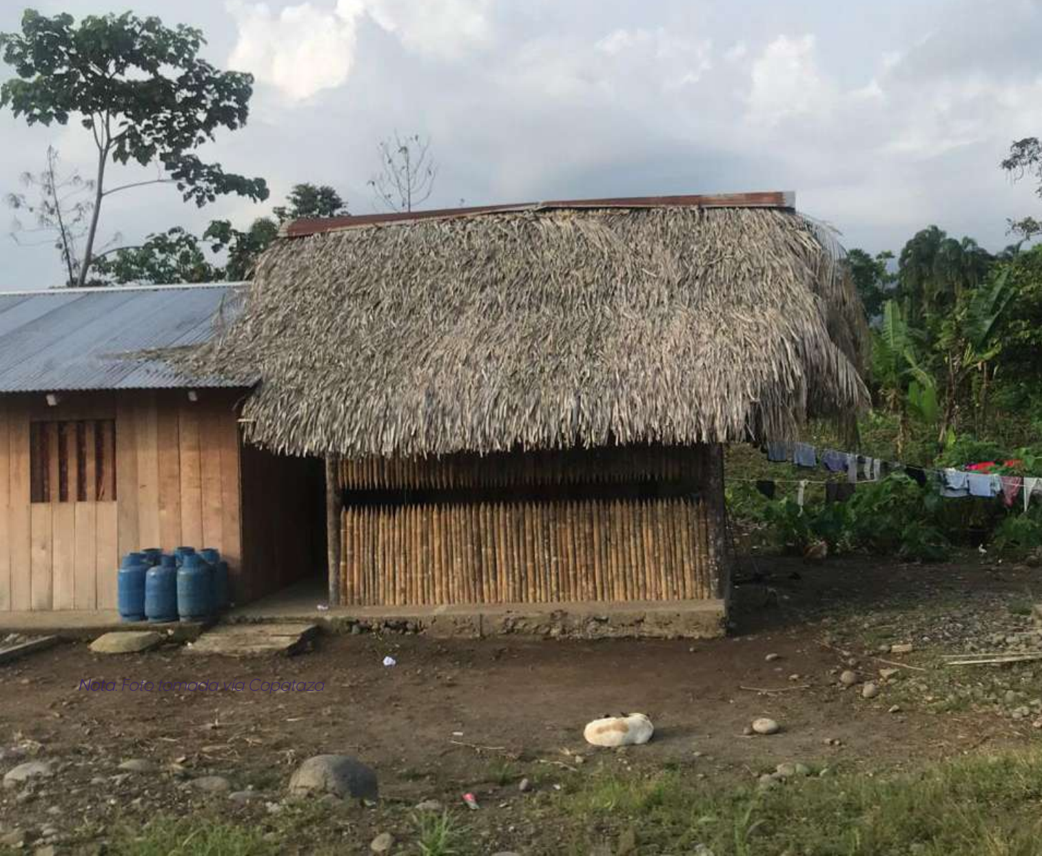
Figura O2. Vivienda sistema constructivo mixto
