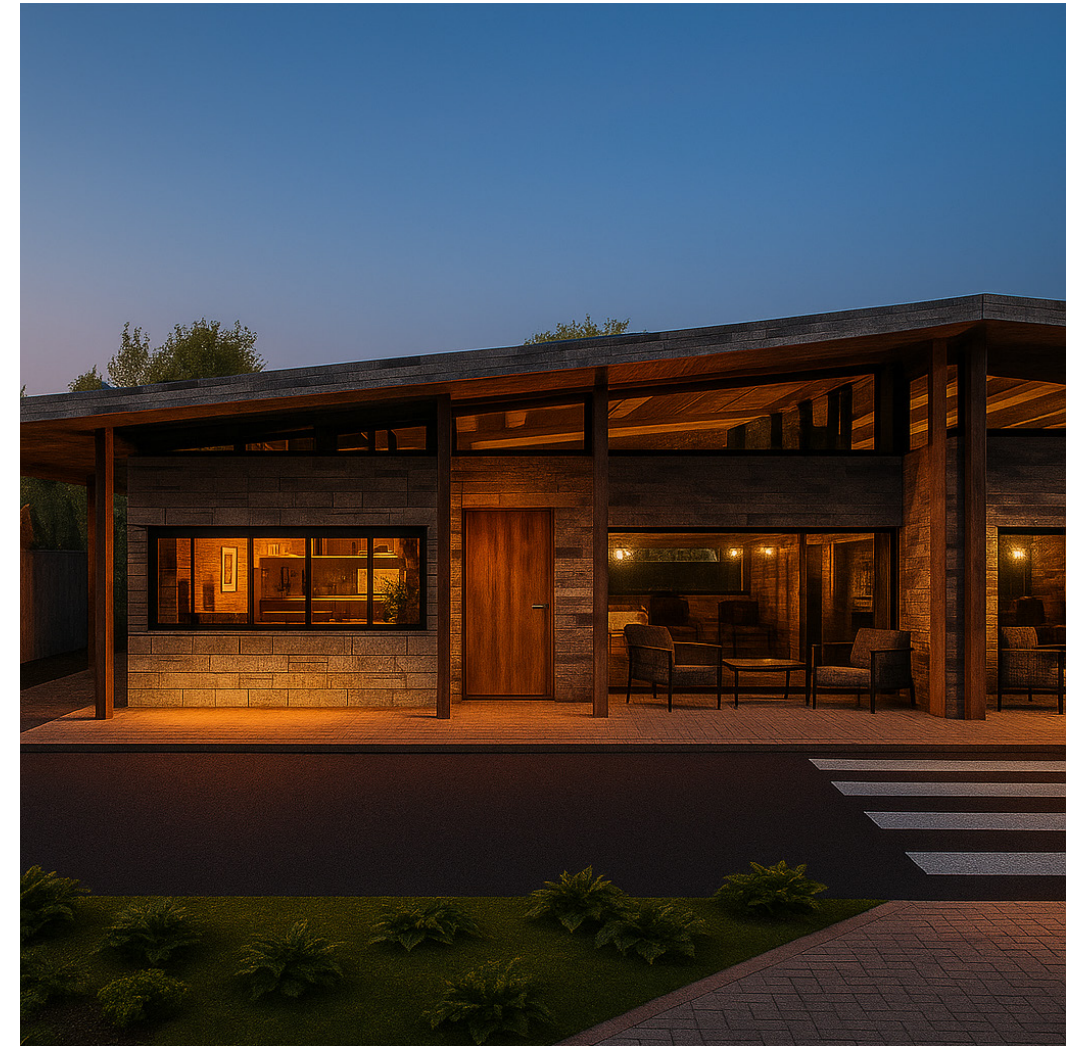
Figura 71. Fachada Frontal de la Vivienda
