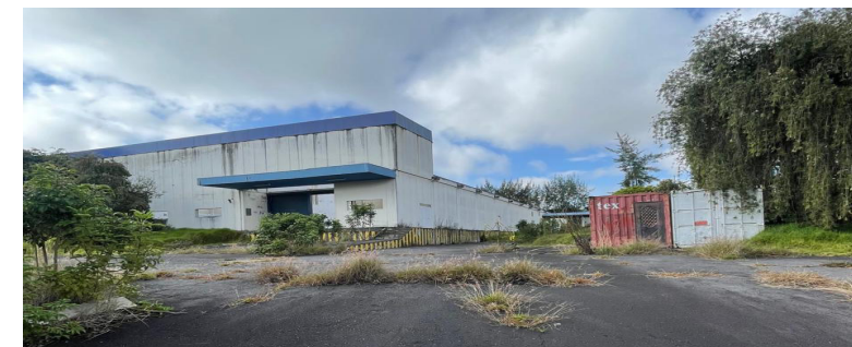
Figura 6. Vista 2 - Abandono del lote Pfizer
