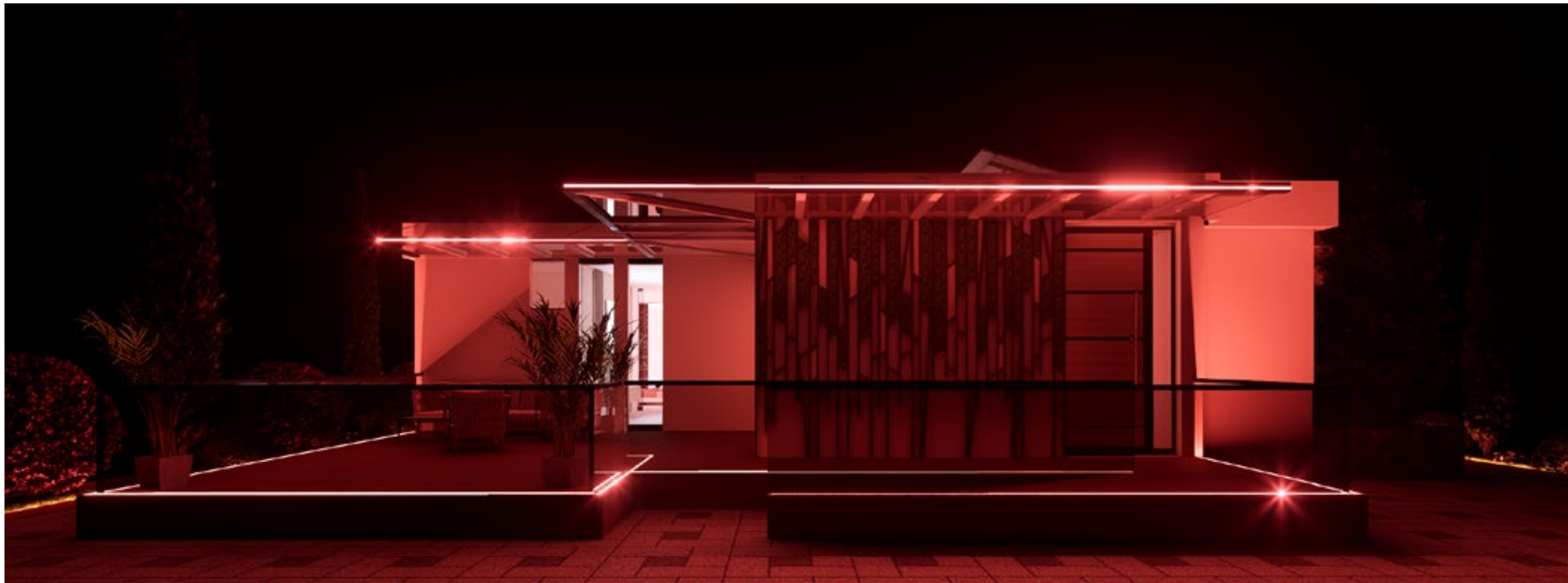
Figura 92. Iluminación en fachada en estado de alerta
