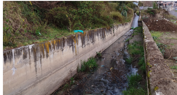
Figura 77. Estado actual del terreno del reservorio
