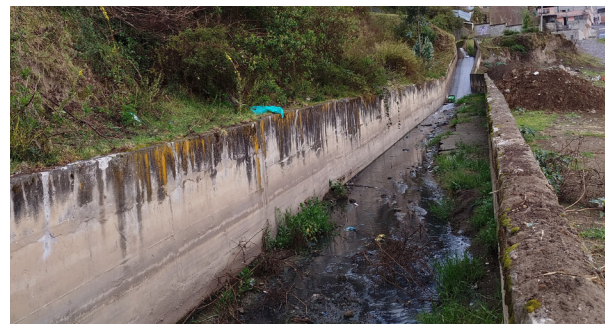
Figura 89. Estado actual del terreno del reservorio
