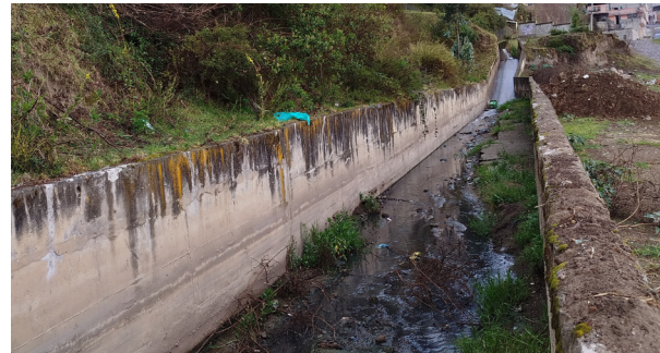
Figura 85. Estado actual del terreno del reservorio
