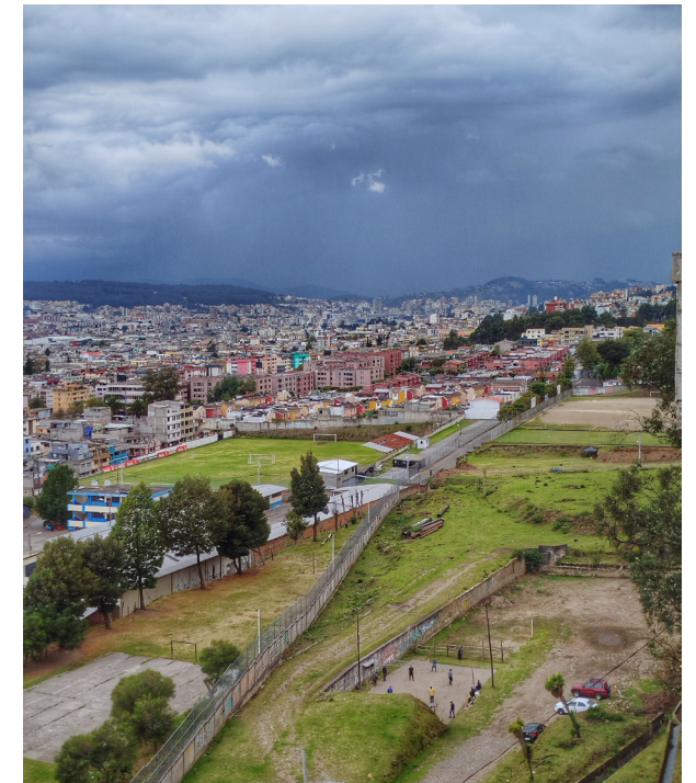
Figura 100. Estado actual del reservorio
