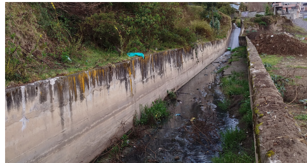
Figura 93. Estado actual del terreno del reservorio
