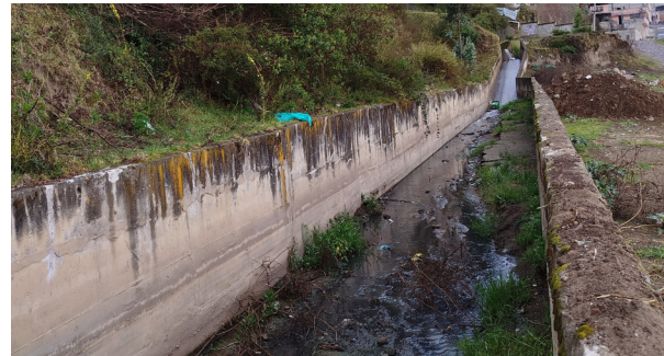
Figura 81. Estado actual del terreno del reservorio
