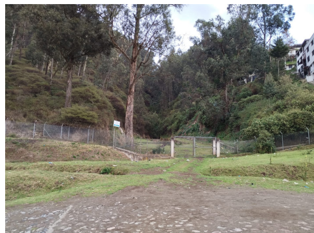
Figura 53. Quebrada Atucucho . - reservorio
