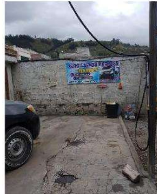
Mala infraestructura de lavadoras
