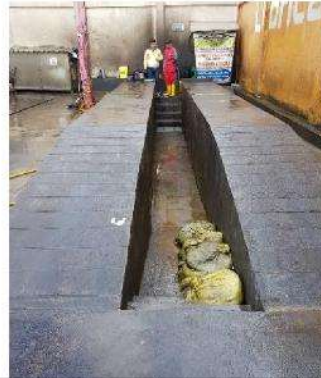
Visita e inspección de trampas de grasa
