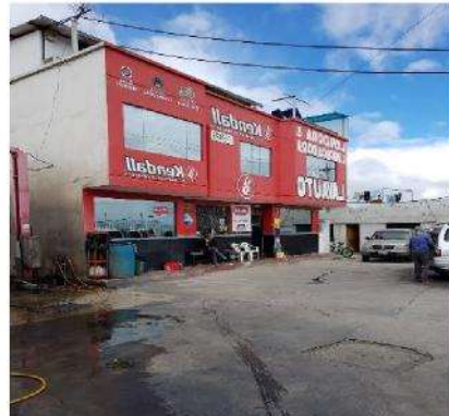
Mal diseño y construcción de la infraestructura
