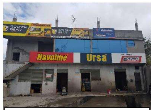
Empresa lavadora que requiere que se mejore su infraestructura
