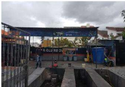
Inspección etapas de trampas de grasa
