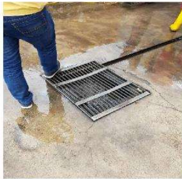
Visita e inspección de trampas de grasa
