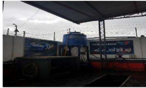
Cisterna de 3 metros cúbicos
