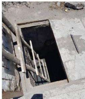
Alcantarillado público lavadora sector rural Ambato
