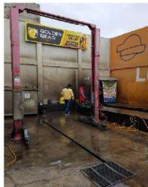
Visita e inspección de trampas de grasa
