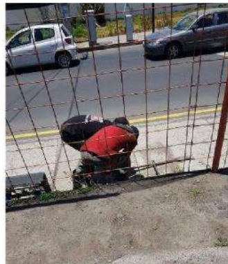
Destape de la alcantarilla
