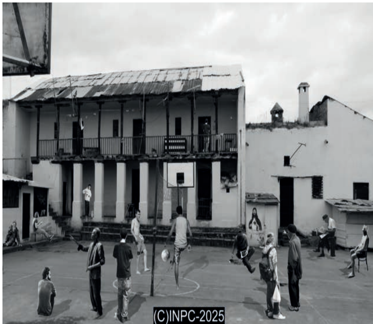
Figura 64 .Imágen de como era antes el Antiguo centro
