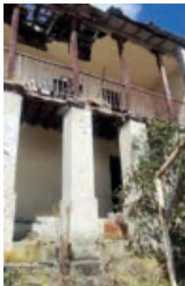
FOTOGRAFÍA 13 Deterioro del techo de la casa, apropiación de la naturaleza con respecto a las gradas y estructura de la casa.
