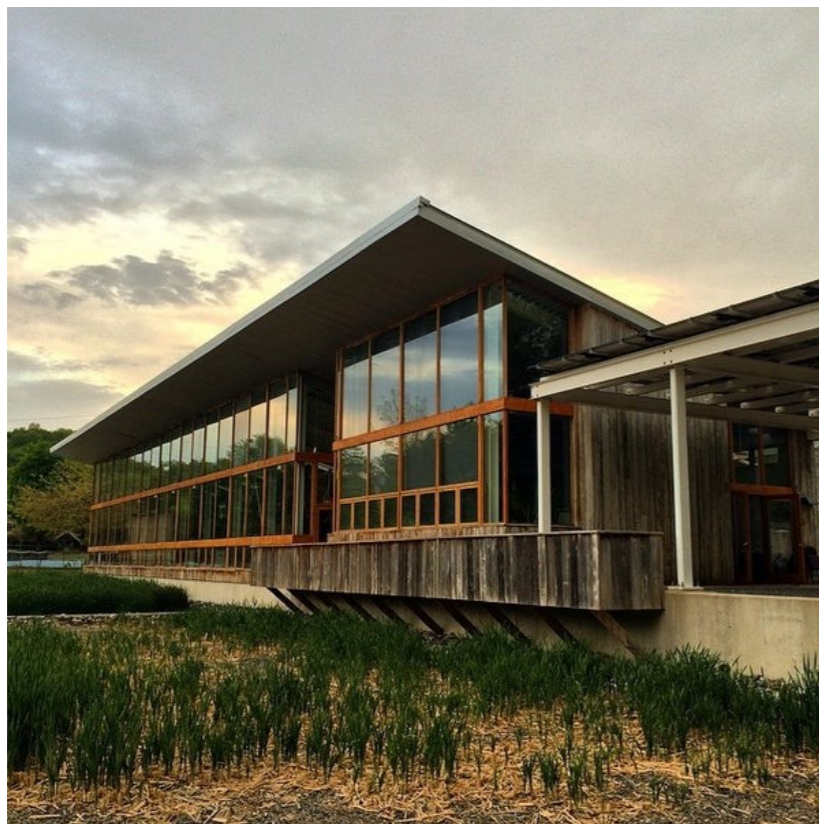
Imagen 27: Detalle sur de la ventana operable
