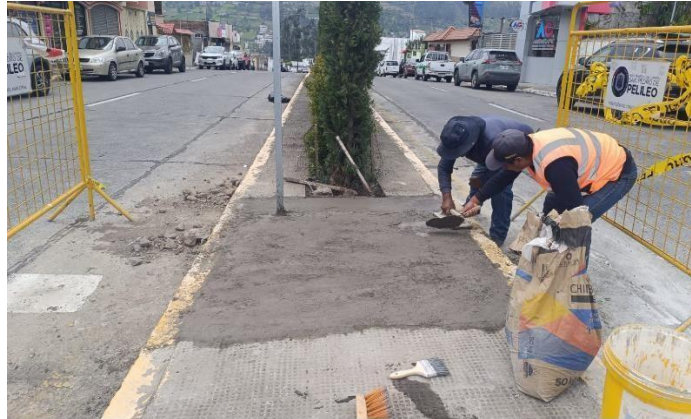
Imagen 4-9: Pavimentación manual en vía activa con disparidad de EPP.
