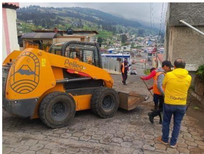
Imagen 4-4: Supervisión de apertura de hueco en calle con mini cargadora.
