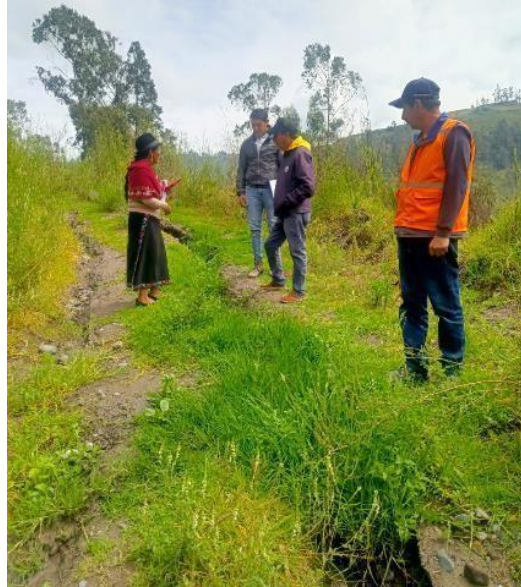
Imagen 4-3: Inspector de Obras Públicas junto a canal de regadío.
