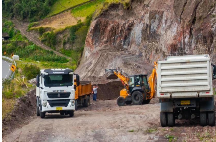
Imagen 4-7: Carga de material pétreo con retroexcavadora en vía rural.
