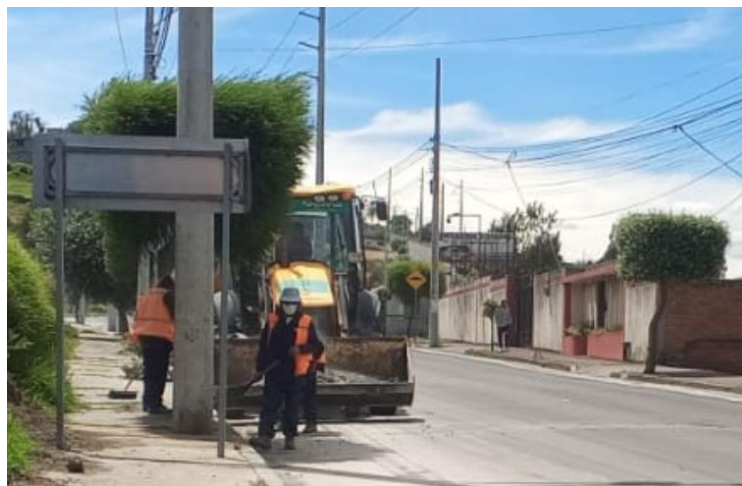
Imagen 4-6: Limpieza de calzada con tractor y exposición a polvo.
