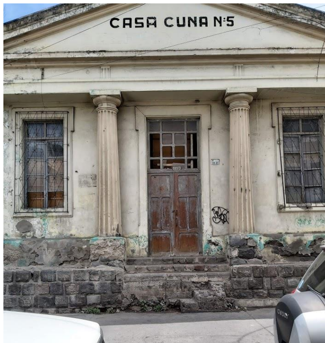
Fotografía 1. Exteriores de inmueble patrimonial
