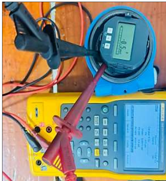
Figura 6. Alimentación al transmisor de presión con el calibrador de procesos.
