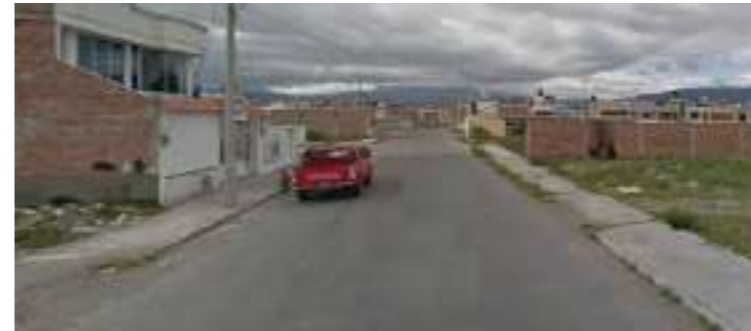
ESTADO ACTUAL CALLE 24 DE MAYO
