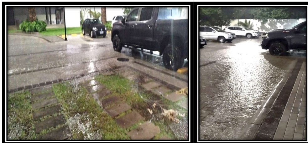
Inundación por escorrentía
