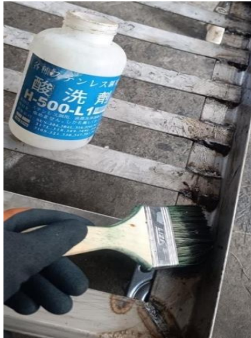
Figura No. 65: Aplicación de ácido limpiador para cordones de soldadura TIG.
