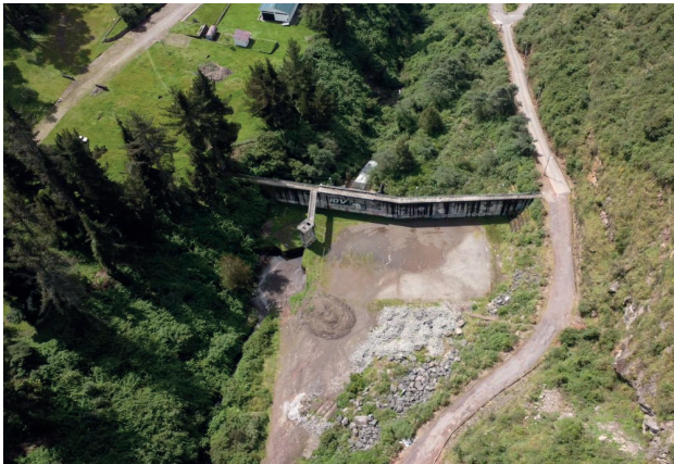
Vista Actual de Cancha a un lado de la Represa Fuente: Elaboración Propia, 2022
