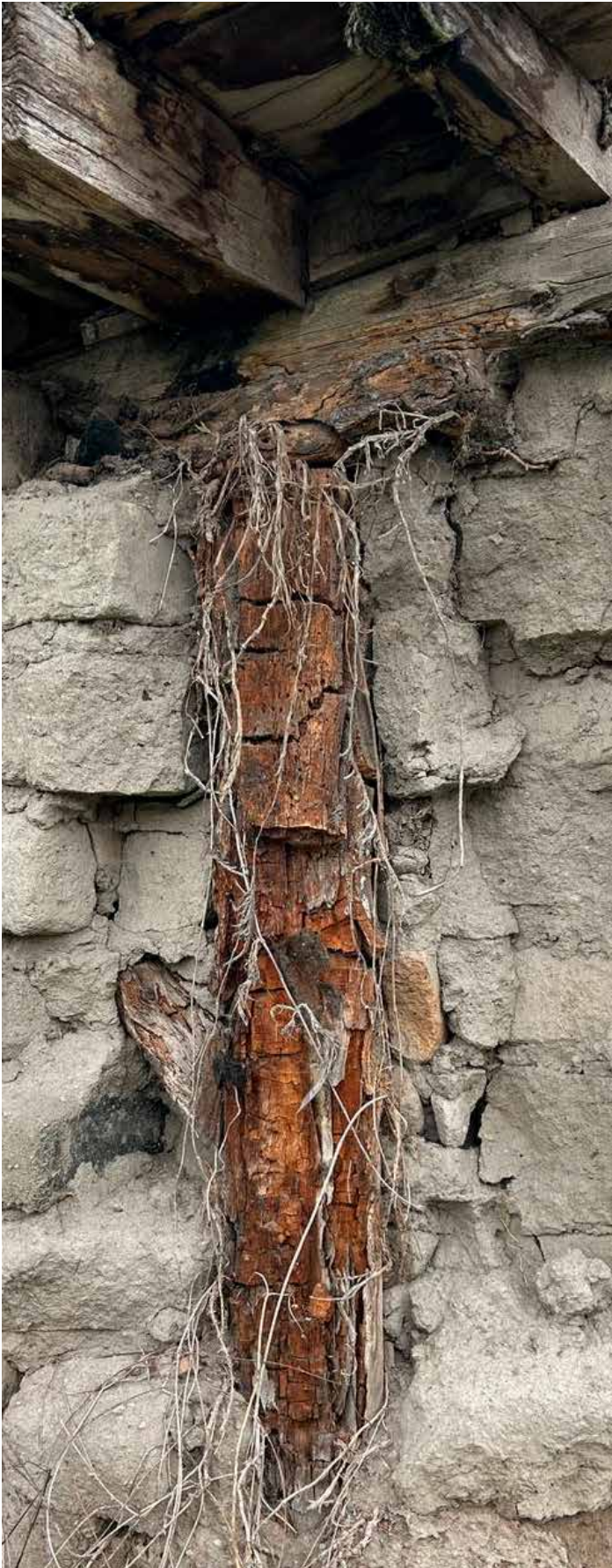
Nota. Conexión de la estructura de madera con el adobe.
