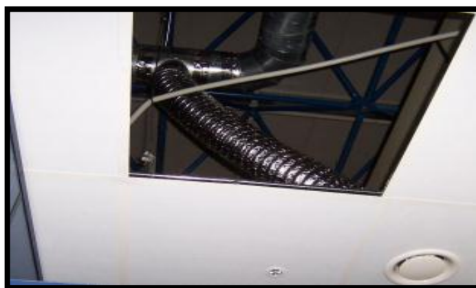
Figura N° 24: Campana de extracción de gases
