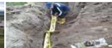
Escasez de fuentes hídricas superficiales
