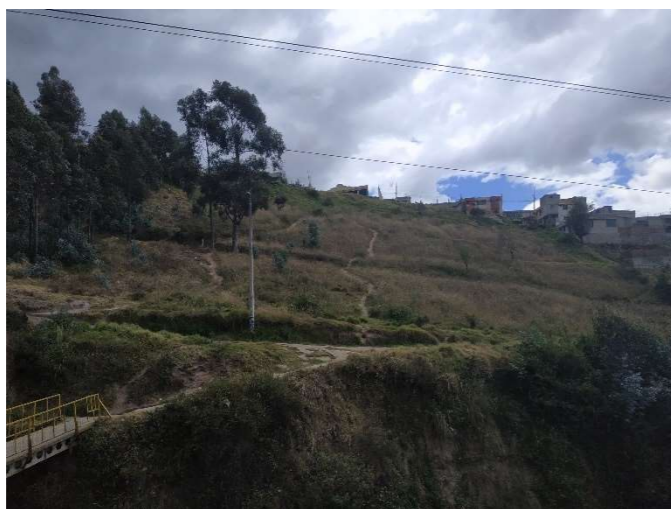
(Ilustración 40: Nivel de Consolidación, fuente: propia (2019))
