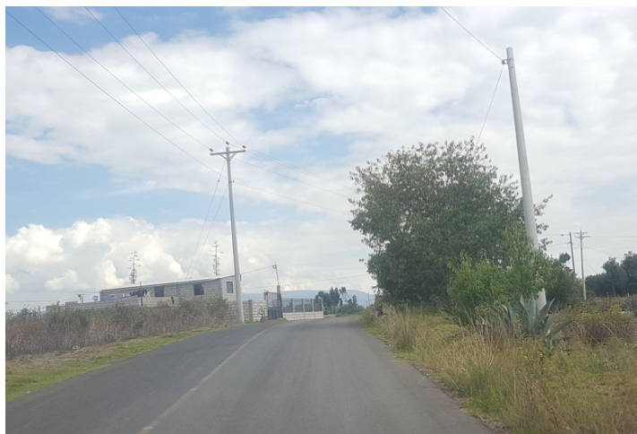
Imagen 25: Postes eléctricos Elaborado por: Diego Tocumbe
