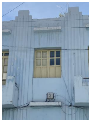
Carpintería de ventanas
