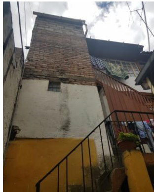
Parte posterior de la edificación
