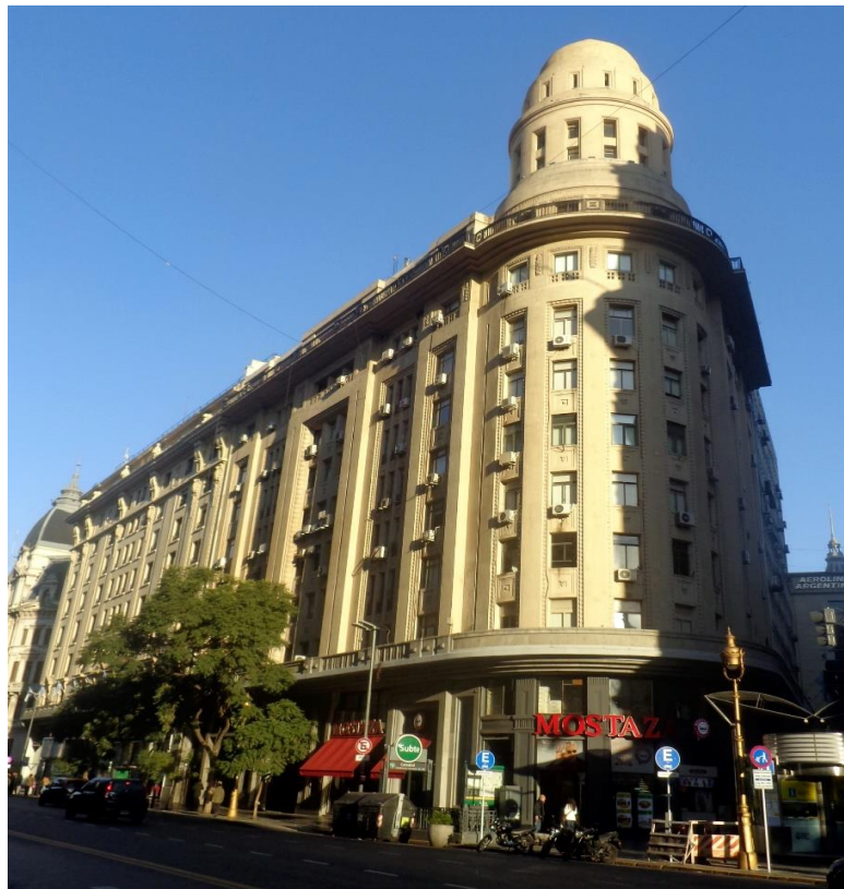
Gráfico 18. Art Deco en Argentina, edificio la equitativa del plata. Fuente: Fiadone.R, (2015)
