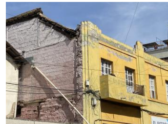
estructura de madera, paredes de piedra y bloque, cubierta de teja artesanal.
