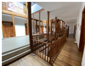
IMAGEN 4 Entrepiso, pasamanos, escaleras de madera
