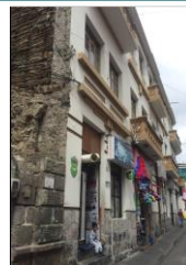
IMAGEN 2 Material de muros bahareque-piedra
