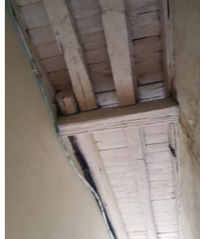
estructura y entepiso de madera
