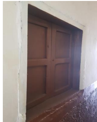
Carpintería de ventanas
