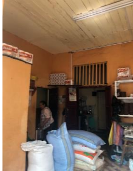
Interior de la edificación
