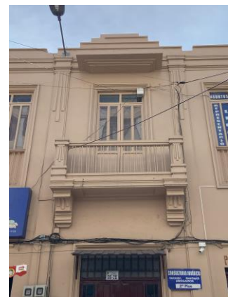
Balcón, alero, marcando centralidad
