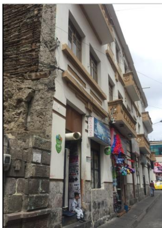
Material de muros bahareque-piedra
