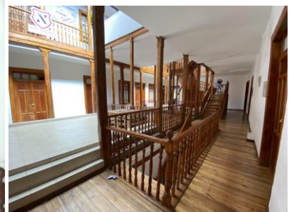
Entrepiso, pasamanos, escaleras de madera
