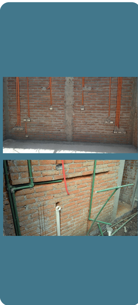
Figura 16. Subsistema de instalaciones tradicional
