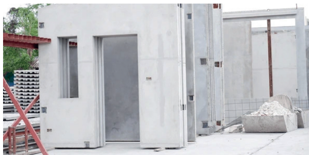
Figura 9. Técnica de prefabricación
