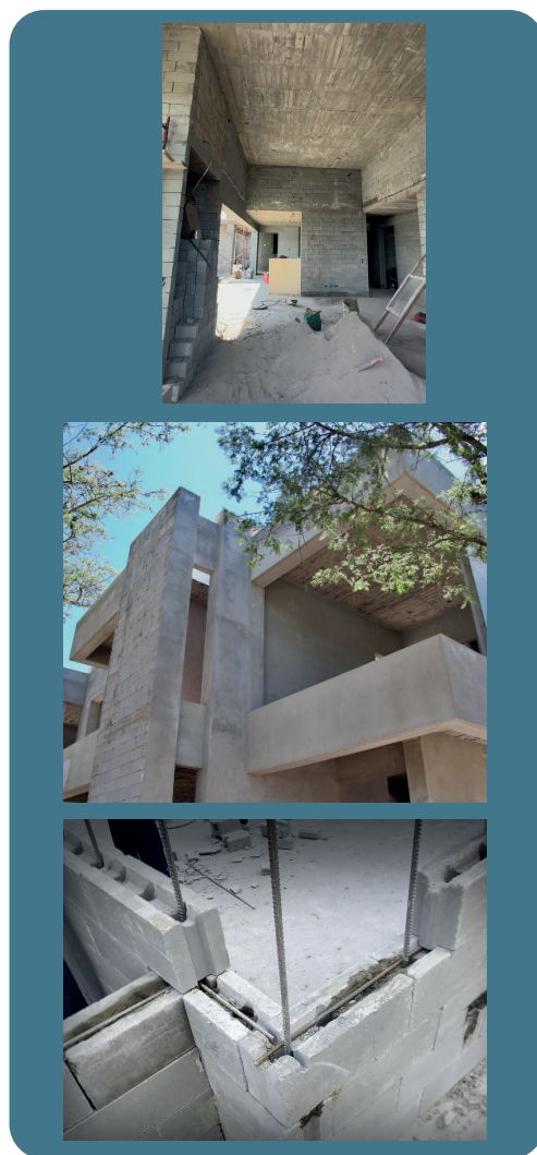
Figura 18. Subsistema de cerramiento boonker
