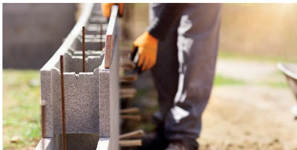
Figura 6. Sistema Constructivo Boonker
