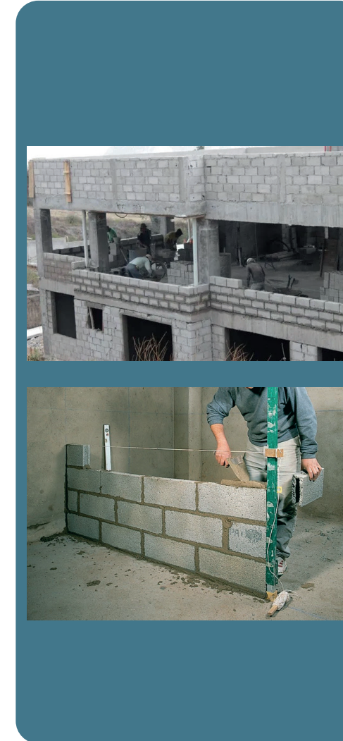
Figura 15. Subsistema de cerramiento tradicional
