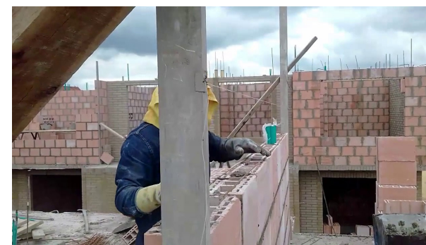
Figura 5. Mampostería método tradicional
