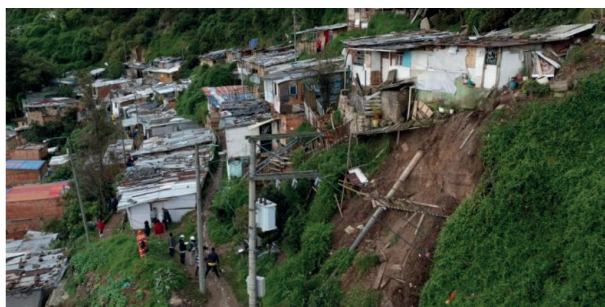
Figura 2. Vulnerabilidad en viviendas
