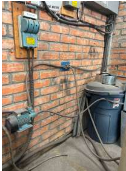
Sistema de enfriamiento para soldadora de punto
