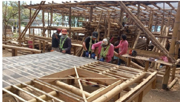
Figura 36. Vivienda en bambu,Nicaragua Fuente: Casa Congo,2021
