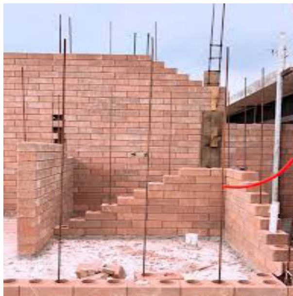
Figura 26. Sistema Constructivo de BTC Fuente: Arquitectura Viva,2022
