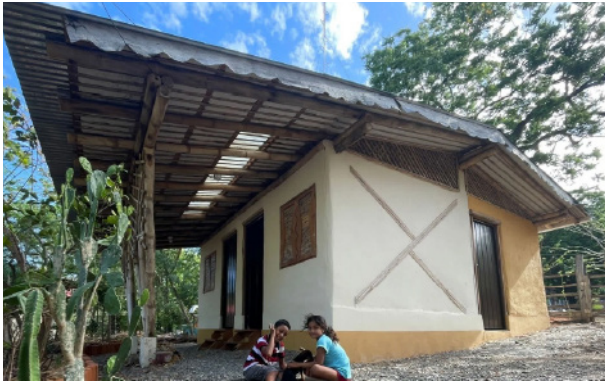
Figura 35. Vivienda en bambu,Nicaragua Fuente: Casa Congo,2021
