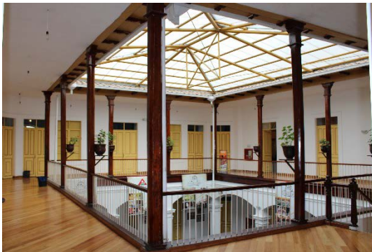
3.Descripción: Galerías y cubierta del patio interior. Fuente: El autor.
