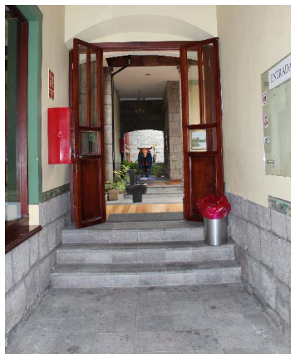
4.Descripción: Escalinatas de acceso, entrada principal. Fuente: El Autor
