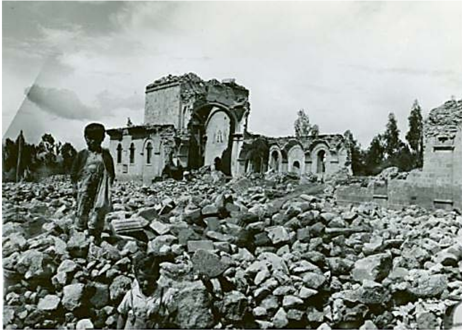
Imagen 13. Ruinas de la iglesia de santa Rosa, provincia de Tungurahua Fuente: www.igepn.edu.ec - USGS
