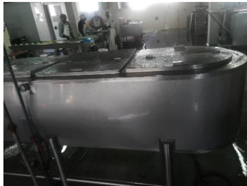
Imagen 17: Tanque de almacenamiento
