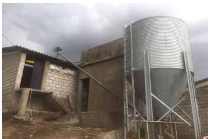
Imagen No. 6 Silo y reservorio del galpón Fuente: Investigación Directa
