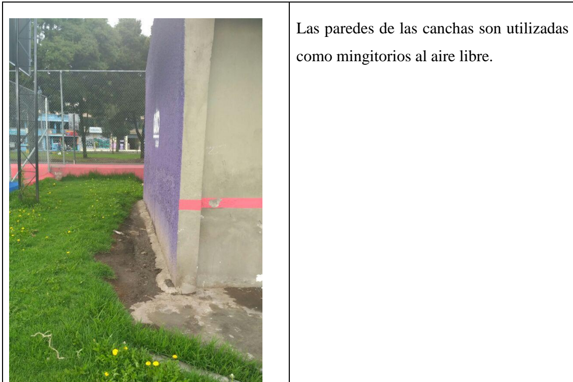
Figura 17. Mantenimiento deficiente de áreas verdes y de circulación.
