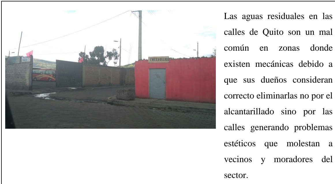
Figura 13. Taller de mecánica que vierte sus aguas residuales a la vía pública
