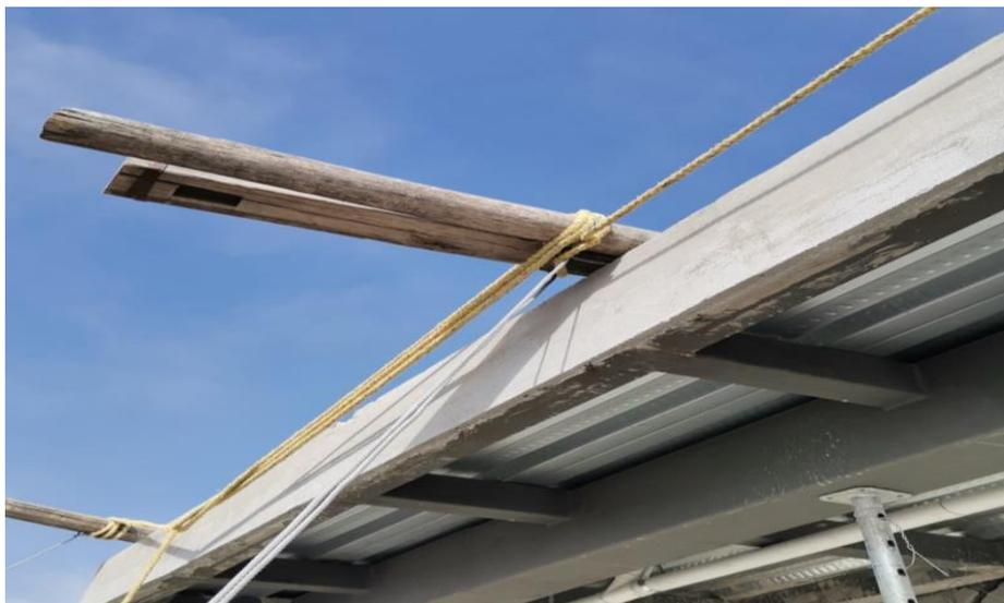
Nota: Se evidencia que la línea de vida horizontal no está instalada con perfil de anclaje.
