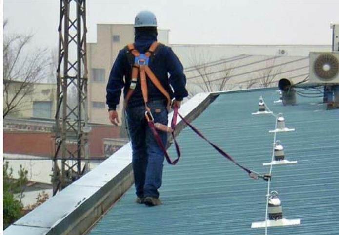
Nota: En la figura 4 se puede evidenciar el buen uso de la línea de vida horizontal para trabajos en altura.
