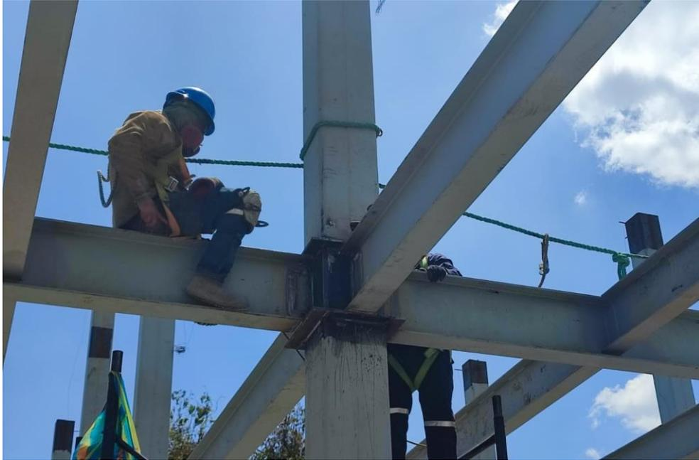
Nota: En la figura 7 se observa que los trabajadores al momento de realizar trabajos en altura utilizan la línea de vida horizontal donde se puede tener caída a distinto nivel y quedar en suspensión.
