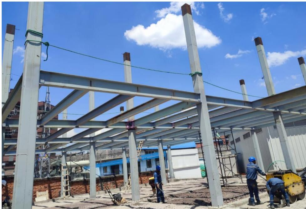
Nota: Se evidencia el mal uso de la línea de vida horizontal que la constructora Talleres HT ocupa para realizar trabajos en altura.
