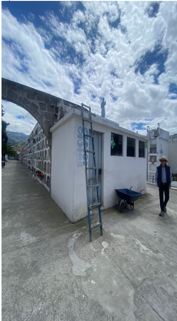
Figura 59. Caseta de área sanitaria antes
