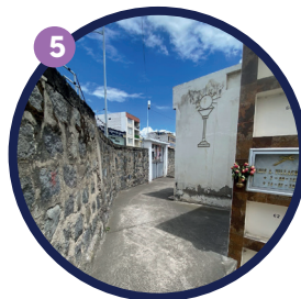
5 ENTRADAS: MEJORA DE LA ACCESIBILIDAD Y FUNCIONALIDAD
